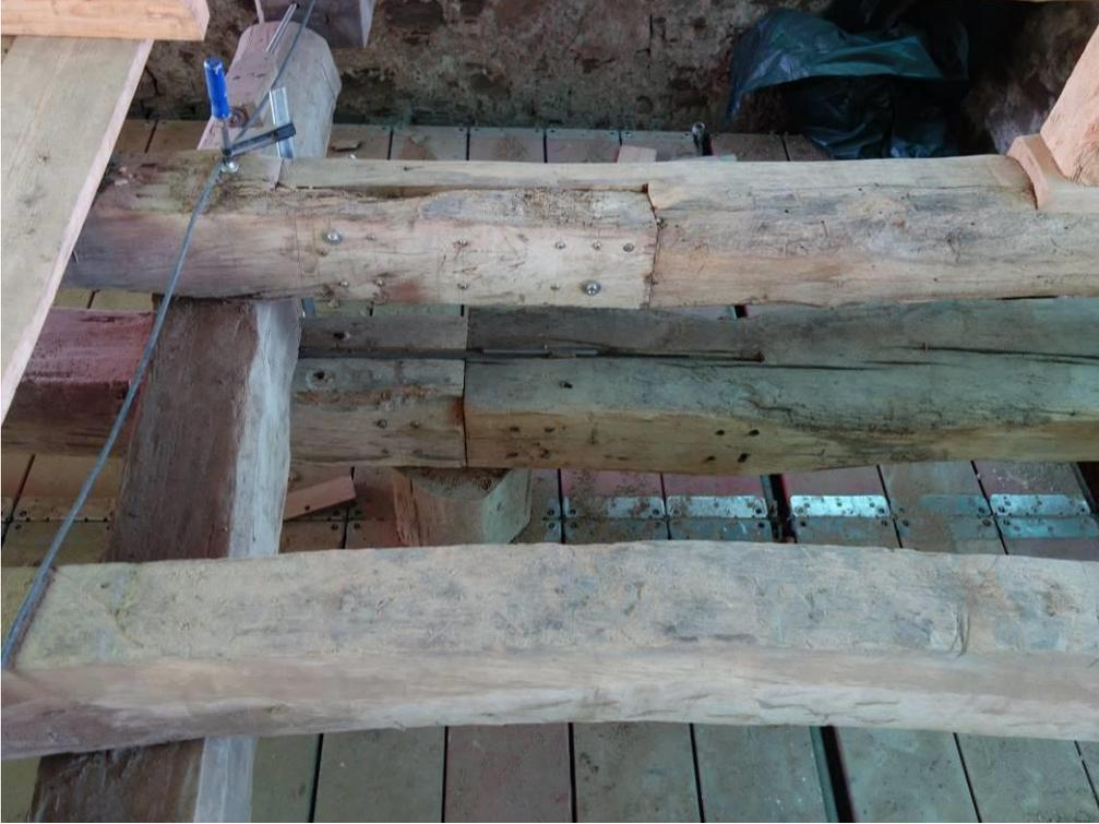
Kompromiss hinsichtlich des Erhaltungszustandes des Bestandholzes (links im Bild). Zuvor ist die Resttragfähigkeit untersucht worden.
