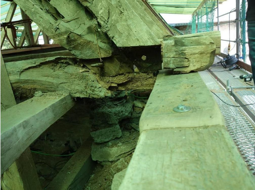
Zerstörter Fußpunkt ermöglicht Einblicke in die Zapfengeometrie.
