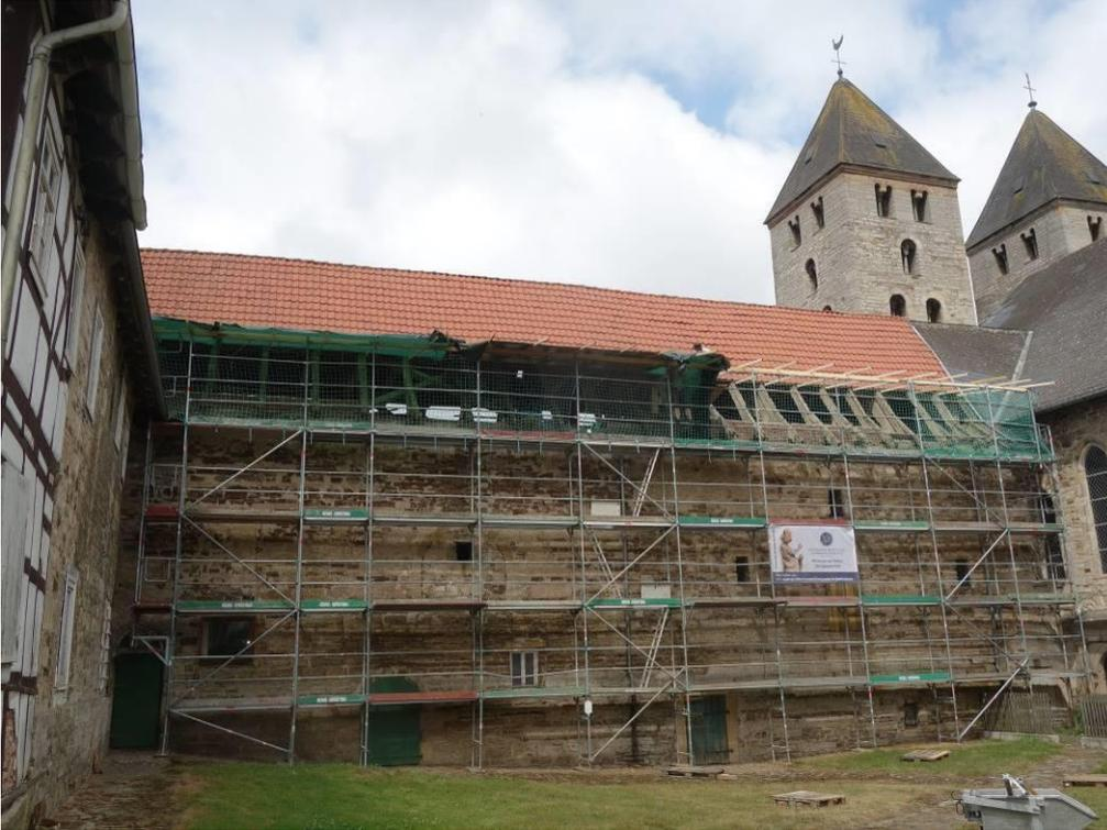
Öffnung der Dachfüße von außen und Überdeckung mit einem provisorischen Schleppdach.
