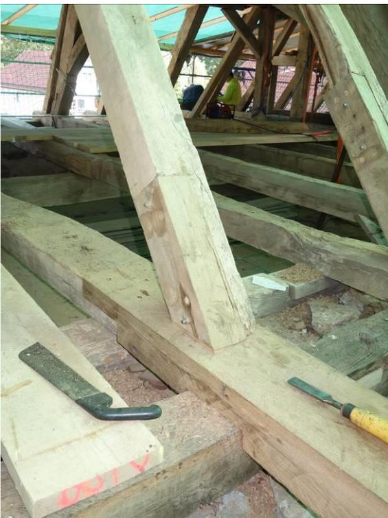
Abgestufte Varianten des Rückschnitts bei Sparrenfuß-Reparatur.
