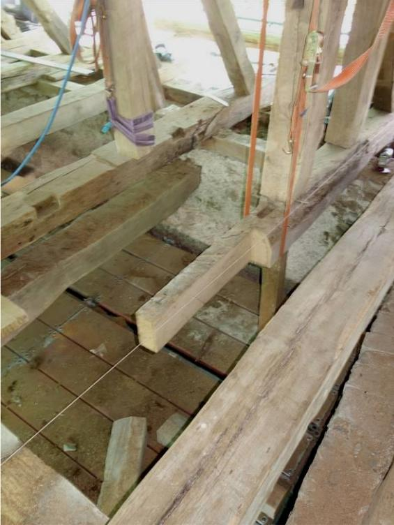
Anschneiden eines stehenden Blattes, hier in Achse 11.
