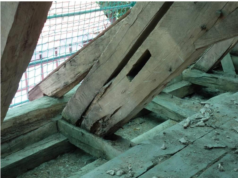
Geschädigter Dachfußpunkt, mit Abbundzeichen und mit Beilspuren für ein Auflager der Dielung
