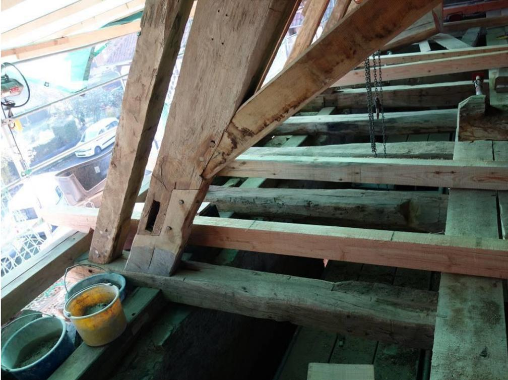
Der Einsatz von Passtücken statt des zunächst geplanten stehenden Blattes ermöglicht den Erhalt der Zapfenlöcher der Auskreuzungen auf beiden Seiten der Stuhlsäule.
