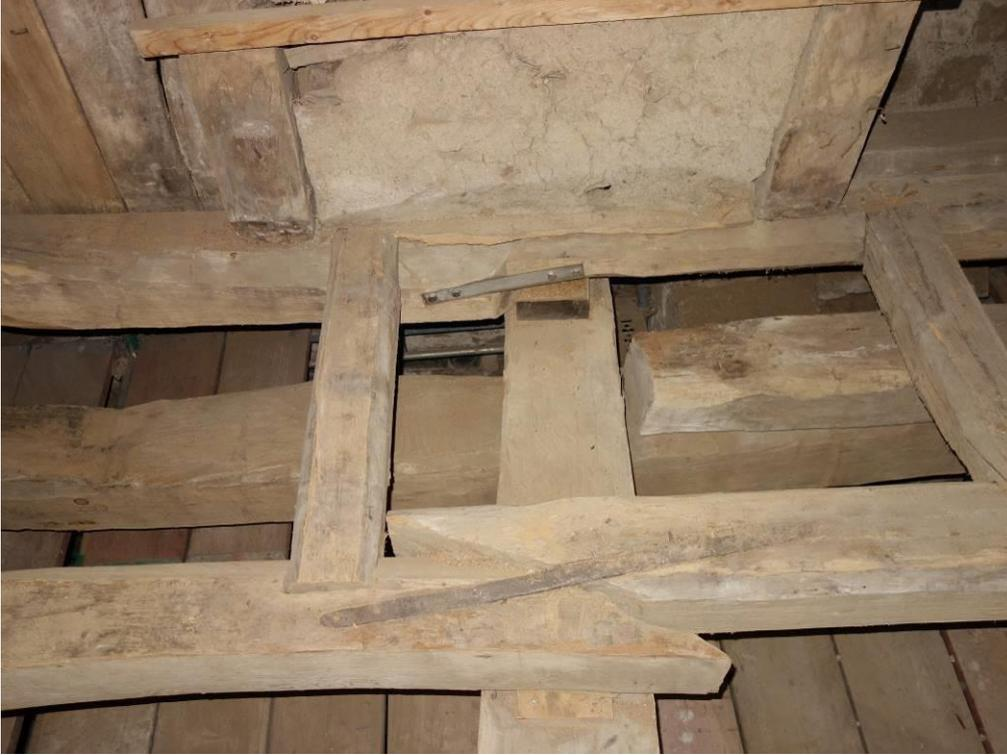
Wiederaufnahme der historischen Technik, mit einer in den Balken eingesenkten Klammer eine Zugverbindung herzustellen.
