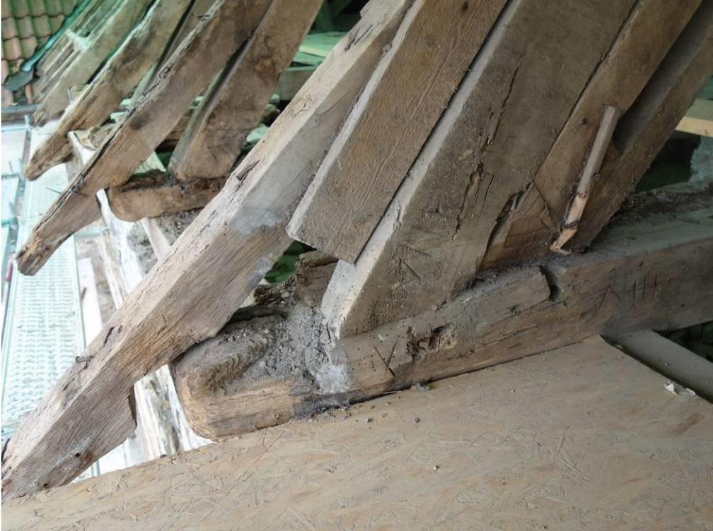
Zerstörter Dachfußpunkt, jedoch mit Abbundzeichen und mit Beilspuren für ein Auflager der Dielung
