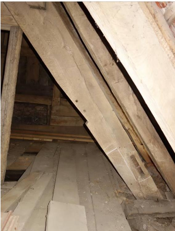
Der Fuß der liegenden Stuhlsäule ist ca.25 cm tief im Deckenbalken versunken.
